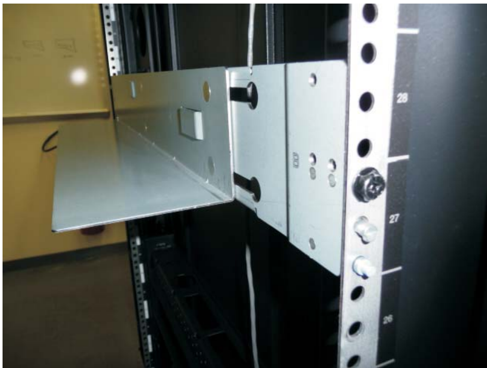
Figure 4-10. Vue arrière du kit de l'armoire B affichant une méthode différente de montage
