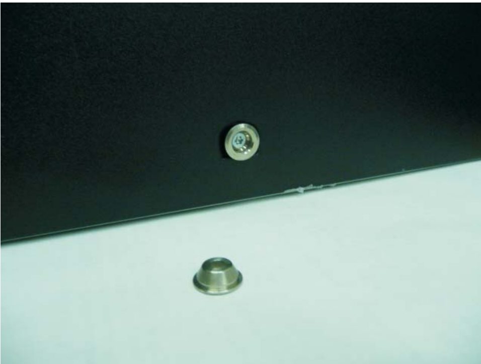
Figure 4-13. Vue rapprochée du montage des ancrage sur les deux côtés de la bibliothèque
